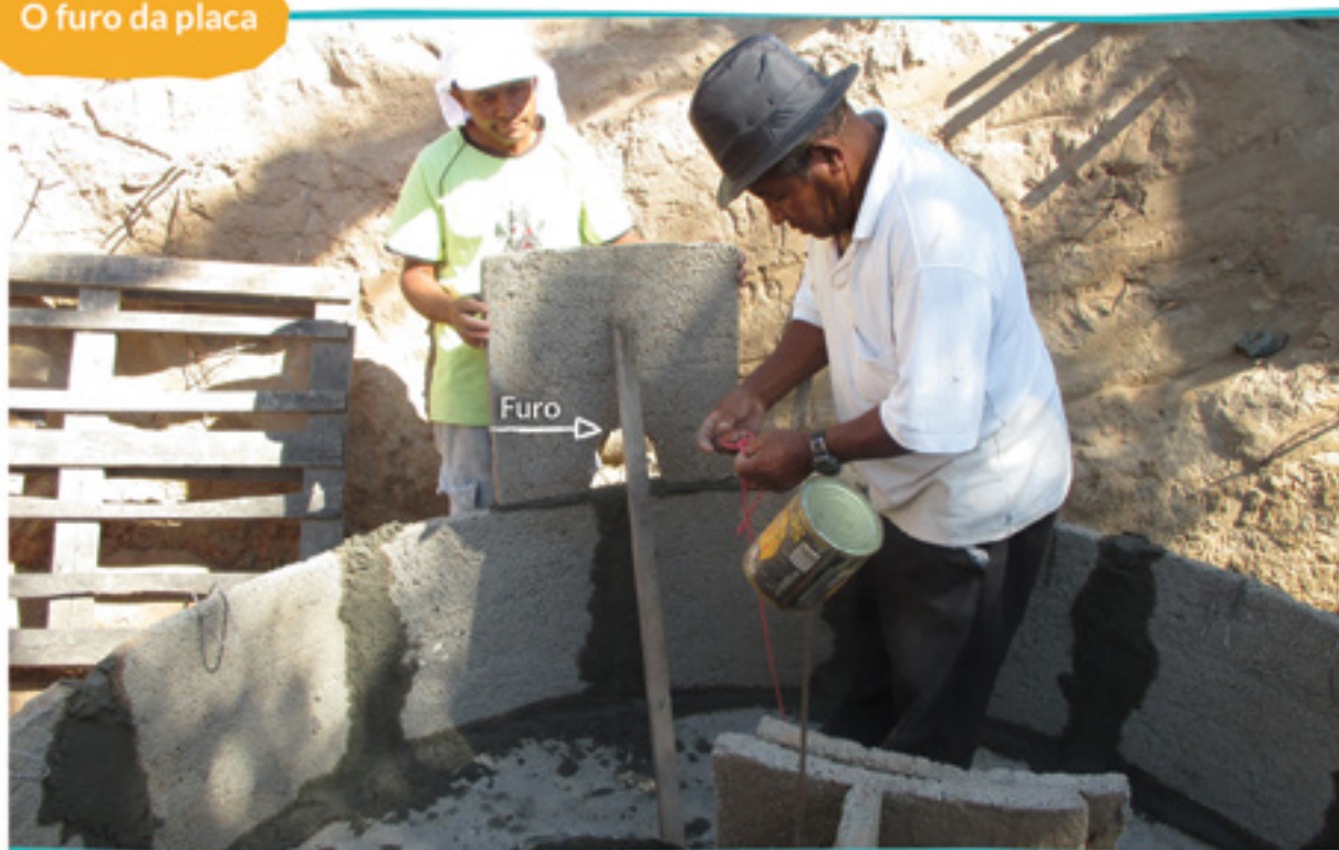
Disposição das placas do Tanque de Fermentação
